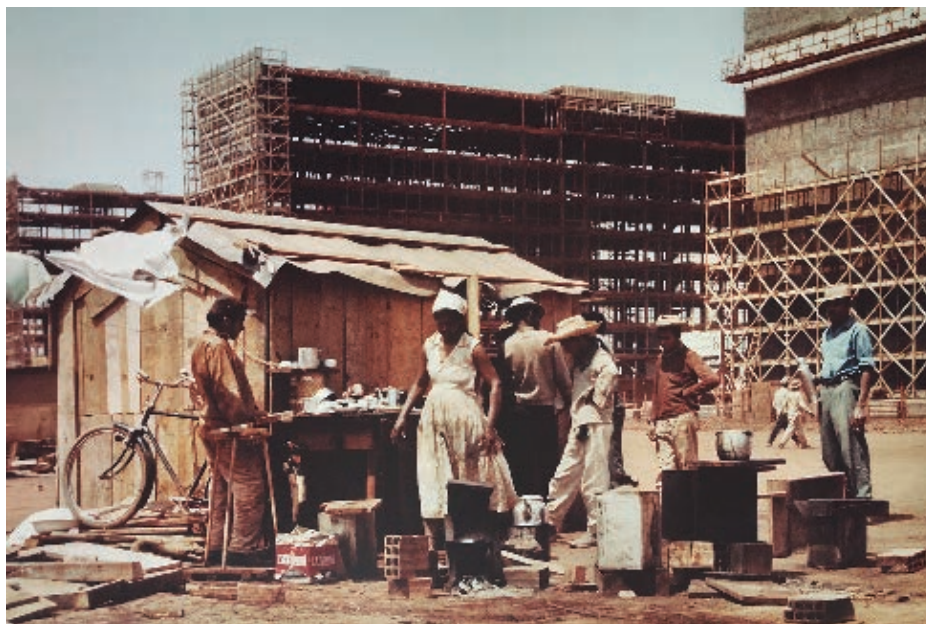
FIGURA 4. CONDICIONES DE TRABAJO DE LOS OBREROS DE BRASÍLIA, JUNTO A LA CONSTRUCCIÓN DE LA EXPLANADA DE LOS MINISTERIOS, C. 1959 (ARQUIVO PÚBLICO DO DISTRITO FEDERAL)
