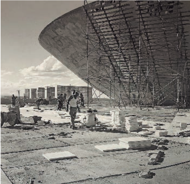
FIGURA 3. COMIENZO DEL LLENADO DE LAS PIEZAS DE HORMIGÓN ARMADO EN LA CÚPULA DEL CONGRESO, BRASÍLIA, C. 1958. MARCEL GAUTHEROT (ACERVO IMS)
