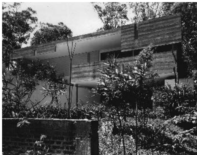
FIGURA 7. CASA ELZA BERQUÓ, PROYECTO DE VILANOVA ARTIGAS, C. 1968. EJEMPLO DE GRAN COBERTURA EN HORMIGÓN ARMADO CARACTERÍSTICO DE LA ARQUITECTURA BRUTALISTA PAULISTANA (ACERVO FAU USP)
