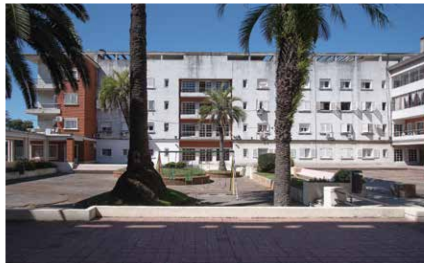
VISTA DEL PATIO PRINCIPAL, DESDE EL OESTE. FOTOGRAFÍA: MARÍA NOEL VIANA, 2022
