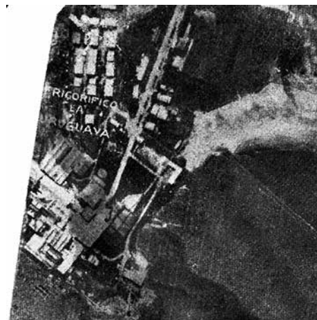
FIGURA 4. RECORTE DE FOTOGRAFÍA CON EL ÁREA DEL PREDIO QUE OCUPABA LA FRIGORÍFICA URUGUAYA. AL NORTE DE LA FÁBRICA (PARTE SUPERIOR DE LA IMAGEN), SE OBSERVAN LAS VIVIENDAS E INSTALACIONES COLECTIVAS. AUTOR: AEROFOTOS LTDA. (BUENOS AIRES, ARGENTINA), 1926. SISTEMA DE INFORMACIÓN GEOGRÁFICO DE LA INTENDENCIA DE MONTEVIDEO: HTTPS://SIG.MONTEVIDEO.GUB.UY/
