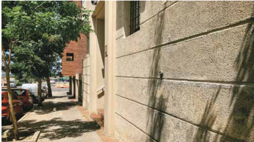
FIGURA 5. VISTA A NIVEL DE PEATÓN POR LA AV. GONZALO RAMÍREZ. APRECIACIÓN DEL BUÑADO EN REVOQUE IMITACIÓN EN HORAS DE LA TARDE. LA RESOLUCIÓN DE LOS PORTALES DE ACCESO OFRECE UNA LEVE DIFERENCIA, CON VOLÚMENES SALIENTES, SIN PASIVAS. FOTOGRAFÍA: PABLO CANÉN, 2023.
