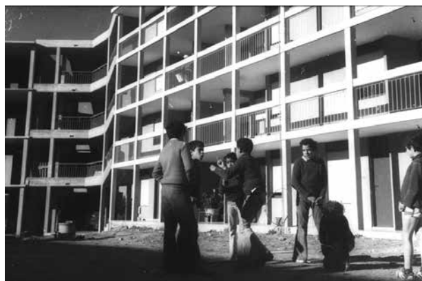
FIGURA 11. COOPERATIVA JOSÉ PEDRO VARELA, ZONA 1. RITMO NEUTRO DE LAS FACHADAS INTERNAS EN LOS BLOQUES DE LAS COOPERATIVAS COVISUNCA Y COVIADDOM. FONDO CUBRÍA, CENTRO DE DOCUMENTACIÓN DEL IH, FADU, UDELAR.
