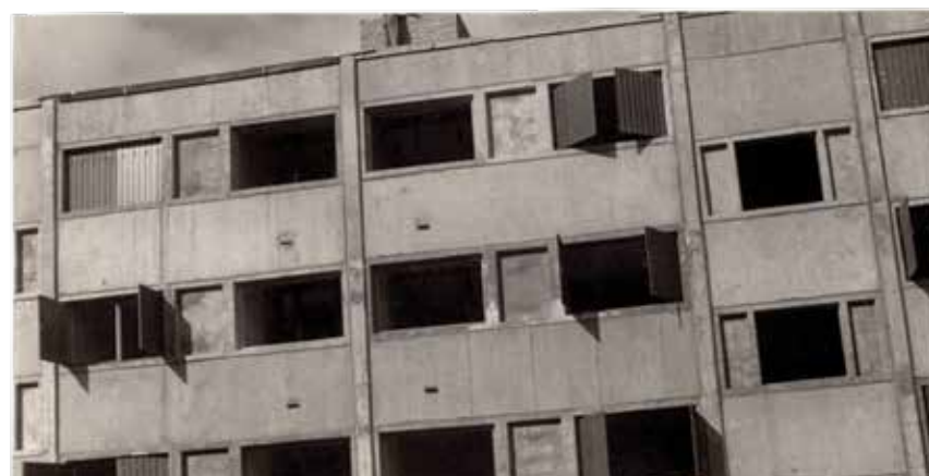
FIGURA 9. FOTOGRAFÍAS DEL SISTEMA CONSTRUCTIVO PNV EN LA EXPANSIÓN 16A. TESIS 543 N. PÉREZ QUINTANA, 1982. BIBLIOTECA DE LA FADU-UDELAR.
