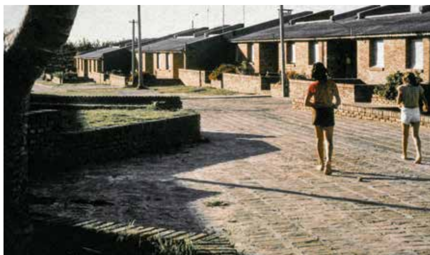
FIGURA 18. VISTA DE LA CALLE INTERIOR DE LA COOPERATIVA ÉXODO DE ARTIGAS, EN FRAY BENTOS. FONDO MARIO SPALLANZANI, CENTRO DE DOCUMENTACIÓN DEL IH, FADU, UDELAR.
