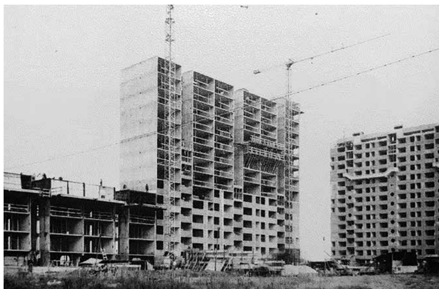
FIGURA 15. FOTOGRAFÍA DE LA CONSTRUCCIÓN DEL PARQUE MALVÍN ALTO CON SISTEMA OUTINORD. FONDO DE LOS CAMPOS, PUENTE Y TOURNIER. CENTRO DE DOCUMENTACIÓN DEL IH, FADU, UDELAR.
