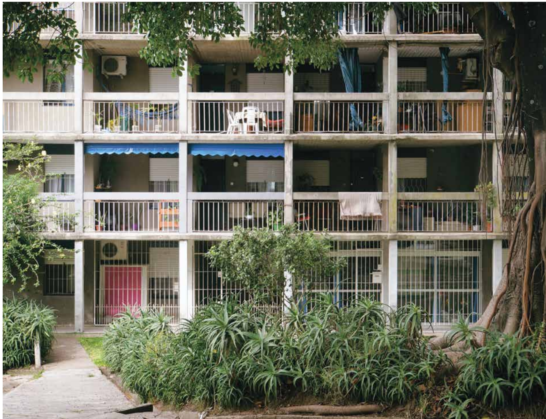
VISTA PEATONAL, DETALLE DE LA FACHADA DE UNO DE LOS BLOQUES Y DE LOS JARDINES EN PLANTA BAJA. FOTOGRAFÍA: PABLO CANÉN, 2021
