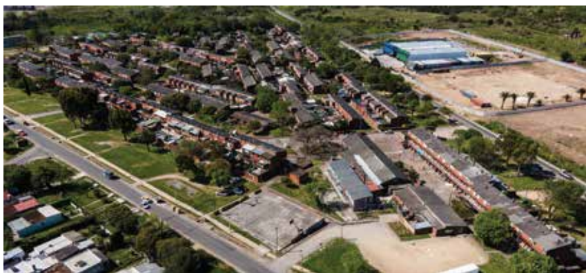
FIGURA 3. COOPERATIVA NUEVO AMANECEER. PERSPECTIVA DEL CONJUNTO A VUELO DE DRON, VISTA DESDE EL SUROESTE. FOTOGRAFÍA: FERNANDO GARCÍA AMEN, 2021.
