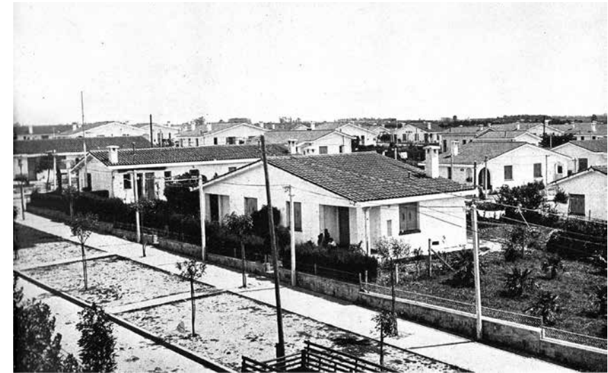
FIGURA 4. FOTOGRAFÍA DEL BARRIO 1. MEMORIA DEL INVE, 1942, P. 21.
