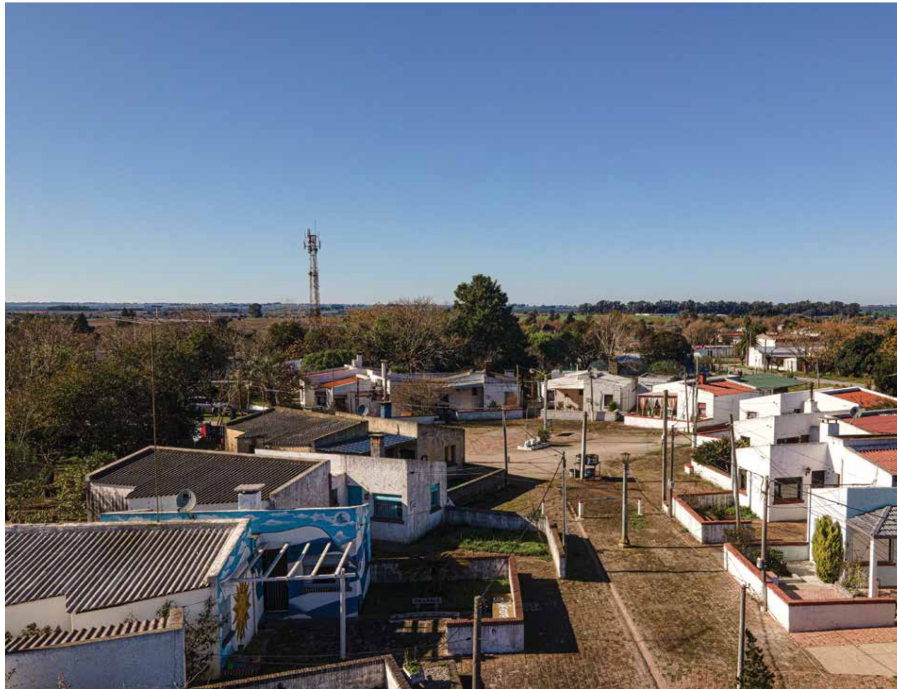
VISTA AÉREA TOMADA A VUELO DE DRON DEL ÁREA CENTRAL DEL CONJUNTO DESDE EL OESTE. FOTOGRAFÍA: FERNANDO GARCÍA AMEN, 2022
