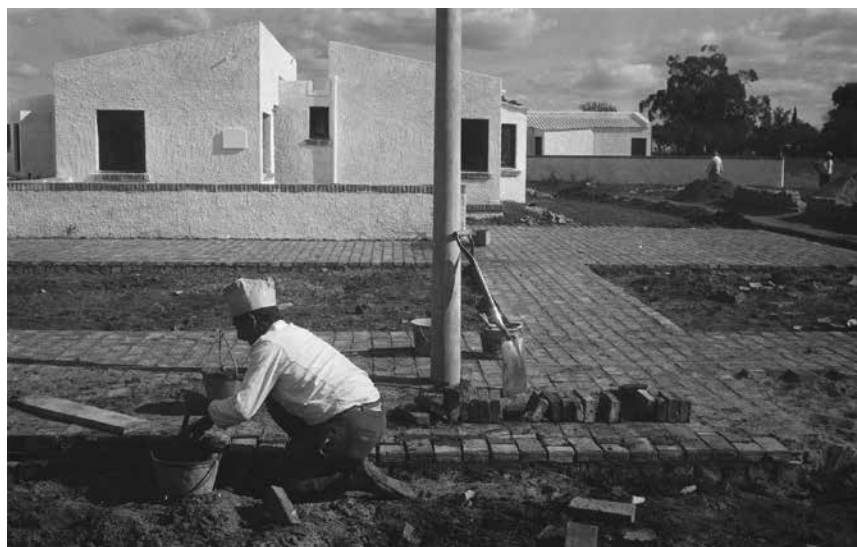
FIGURA 13. COOPERATIVISTA COLOCANDO EL PAVIMENTO DE LADRILLOS EN LAS ÁREAS COMUNES DE LA COOPERATIVA 25 DE MAYO, EN FLORIDA. CENTRO DE DOCUMENTACIÓN DEL IH, FADU, UDELAR.
