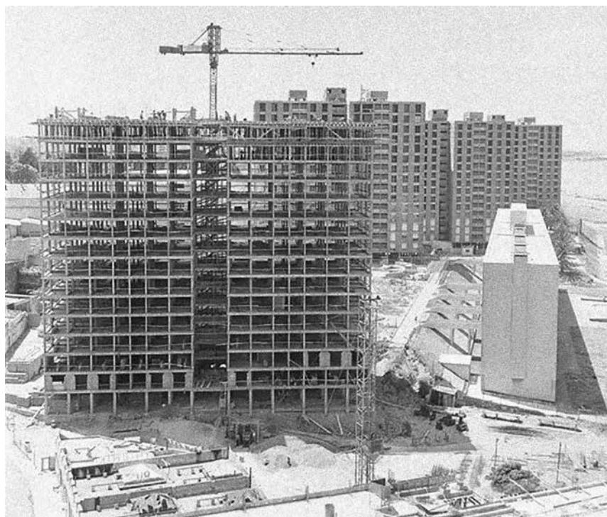
FIGURA 17. FOTOGRAFÍA DE LA CONSTRUCCIÓN DE LA UNIDAD HABITACIONAL BARRIO SUR TOMADA POR JULIO TESTONI. EL DOCUMENTO FOTOGRÁFICO PERTENECIÓ A JULIO CÉSAR ABELLA TRÍAS. ARCHIVO DE LA LIGA DE LA CONSTRUCCIÓN DEL URUGUAY.
