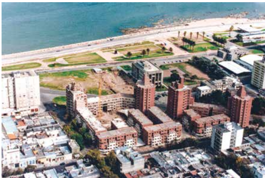
FIGURA 9. FOTOGRAFÍA DEL CONJUNTO EN CONSTRUCCIÓN. ARCHIVO IVÁN ARCOS. COPIA DIGITAL: CENTRO DE DOCUMENTACIÓN DEL IH, FADU-UDELAR. DISPONIBLE EN: HTTPS://NOMADA.UY/GUIDE/VIEW/ATTRACTIONS/4687
