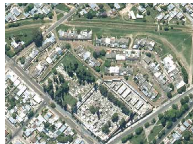
FIGURA 16. VISTA AÉREA DE LA COOPERATIVA ÉXODO DE ARTIGAS 1 Y 2 EN FRAY BENTOS. IDEUY, INFRAESTRUCTURA DE DATOS ESPACIALES, PRESIDENCIA DE LA REPÚBLICA. HTTPS://VISUALIZADOR.IDE.UV/
