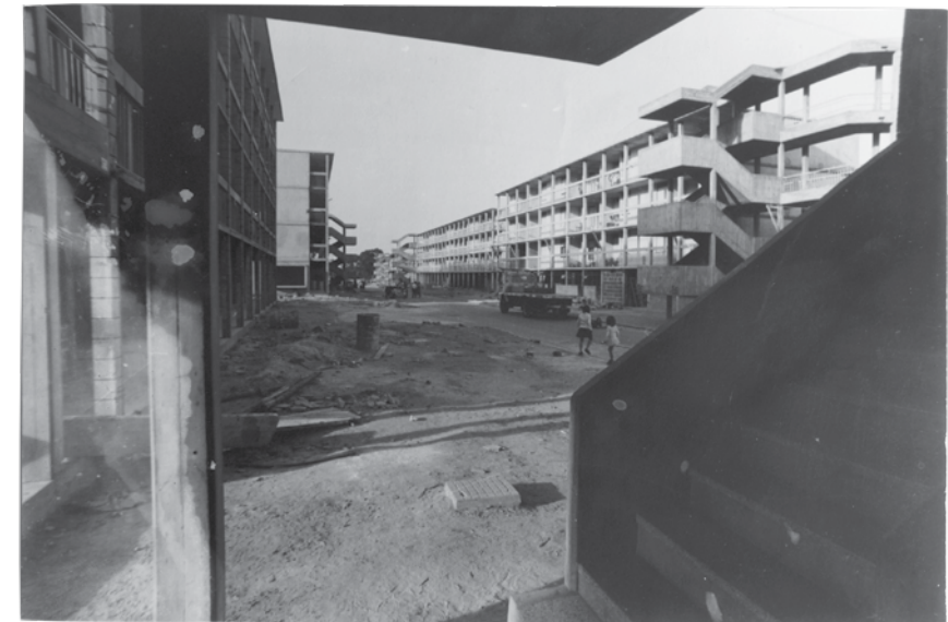
FIGURA 9. COOPERATIVA JOSÉ PEDRO VARELA, ZONA 1. VISTA DE LA RELACIÓN ENTRE LOS BLOQUES Y LA ESTRUCTURA CIRCULATORIA. FONDO CUBRÍA, CENTRO DE DOCUMENTACIÓN DEL IH, FADU, UDELAR.
