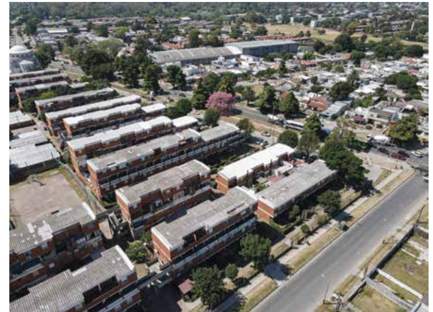
FIGURA 21. COOPERATIVA JOSÉ PEDRO VARELA, ZONA 6. VISTA DEL CONJUNTO, CON LAS CALLES ELEVADAS EN LAS TIRAS DE DÚPLEX SOBRE DÚPLEX. FOTOGRAFÍA: MARTÍN CAJADE, 2023.
