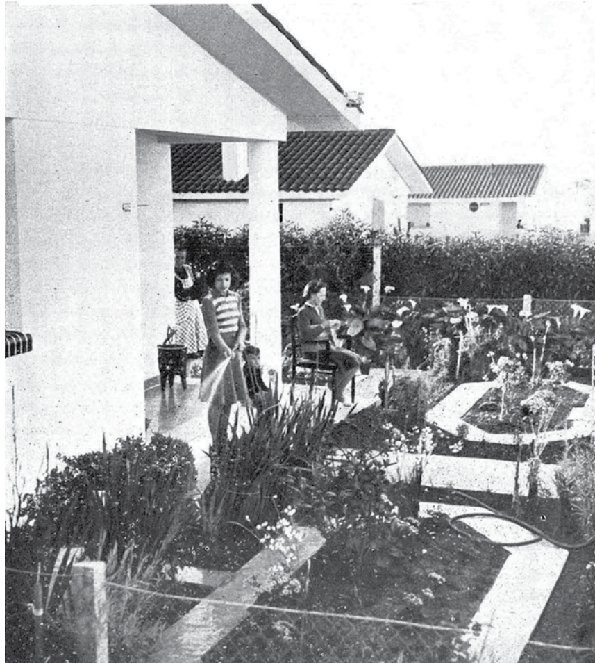
FIGURA 5. FOTOGRAFÍA DEL BARRIO 1. MEMORIA DEL INVE, 1942, P. 27.
