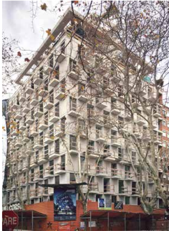
FIGURA 9. VISTA DE LA CONSTRUCCIÓN DEL EDIFICIO ALMA CORSO, PROYECTO DE CARLOS OTT. FOTOGRAFÍA: PABLO CANÉN, 2019.
