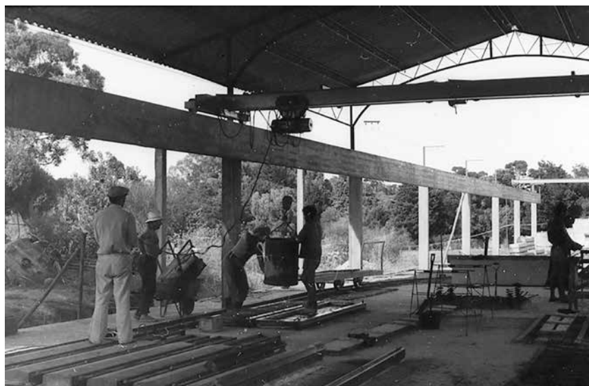
FIGURA 22. COOPERATIVISTAS EN LA PLANTA DE PREFABRICADOS UBICADA EN LA ZONA 3 DEL CONJUNTO JOSÉ PEDRO VARELA. FONDO CUBRÍA, CENTRO DE DOCUMENTACIÓN DEL IH, FADU, UDELAR.
