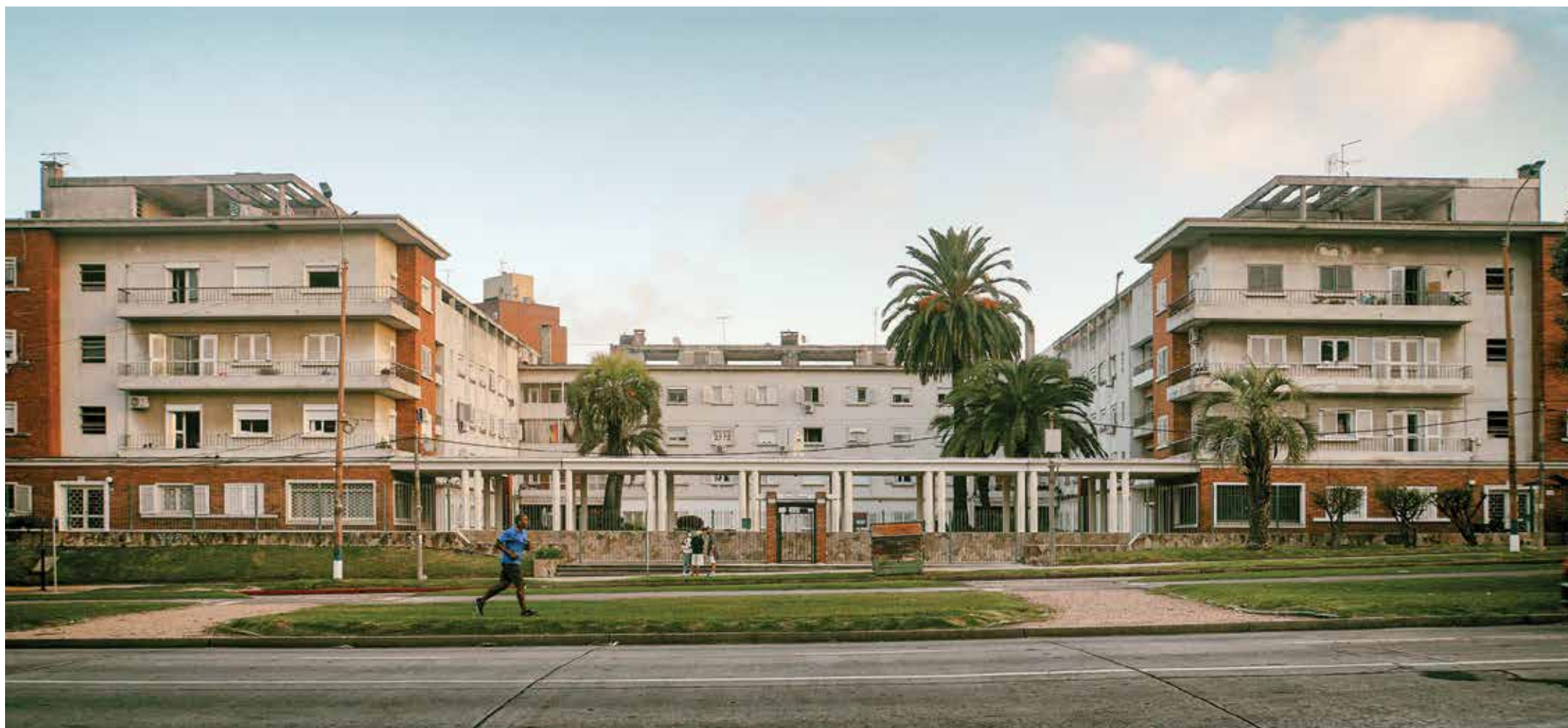
VISTA PEATONAL DEL CONJUNTO, DESDE EL NORTE, POR AVENIDA ITALIA. FOTOGRAFÍA: PABLO CANÉN, 2021
