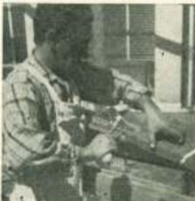
F8. EJECUCIÓN DE LA BOVEDA DE DOBLE CURVATURA. Se observa que en este caso, las piezas cerámicas fueron colocadas a soga, contrariamente a la disposición tradicional a tizón. En nuestros trabajos posteriores, volvimos al despiece tradicional ya sea con traba o a junta continua, para los casos de autoportancia, generalmente.
