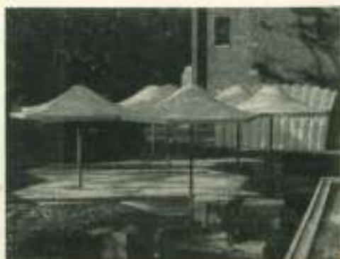
Después de todos los minuciosos estudios y ensayos realizados con espumas de plástico rigidizada como material estructural, el equipo de investigadores llegó a la conclusión que se habían logrado resultados positivos en cuanto a su empleo en Arquitectura, desde el punto de vista estructural, térmico y acústico. El costo se estimó aceptable dado que todo se construyó a nivel experimental.
