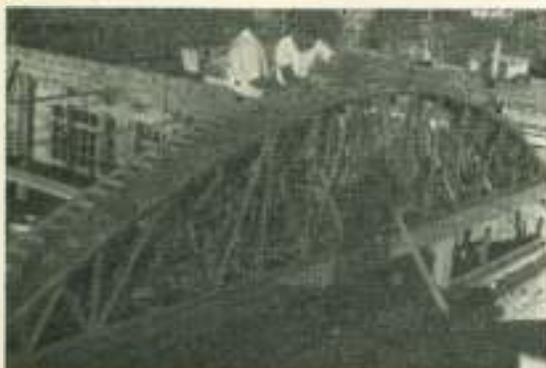
FIG. PRIMER POSICIONADO DE UNA CIMBRA DE m. 8,50 DE LUZ PARA BOVEDA DE CAJON DE DIRECTRIZ CATEGORICA. Puede apreciarse el despiece marcado por las bandas y la colocación de la primer hilada.
