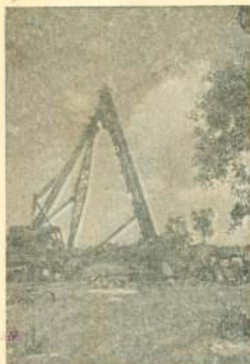
MAQUINA DE PILOTES DE HINCA DE TUBO CONSTRUYENDO PILOTES INCLINADOS PARA LA FUNDACION DEL PUENTE PASO DE LA CADENA (RUTA 64) DE LA DIRECCION DE VIALIDAD (M.O.P.)
