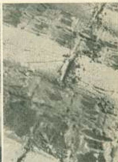
F13. NERVIOS, CON LAS HENDIDURAS PARA EL PASAJE DE LAS ARMADURAS LONGITUDINALES.
