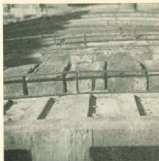
F12. POSICIONADO DE LA ARMADURA-NERVIO CADA 2 HILADAS.
