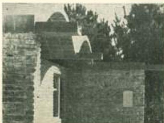
**FIG. 18.** VIGAS DE BORDE Y CANALONES, EXPRESADOS UNITARIAMENTE EN LA SOLUCIÓN DE LOS DETALLES DE TODOS LOS ENCUENTROS DE LAS PIEZAS DE CERÁMICA.
