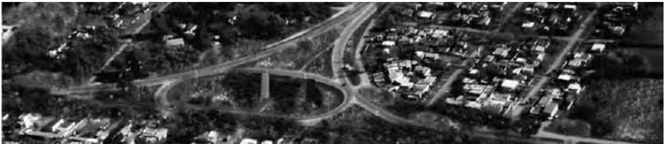
Figura 4. Nodo infraestructural ruta 101-ruta 102. Fuente: Imagen producida por APT Consultora
