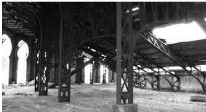
Figura 1. Espacio bajo gradas prefabricadas Fuente: elaboración propia
