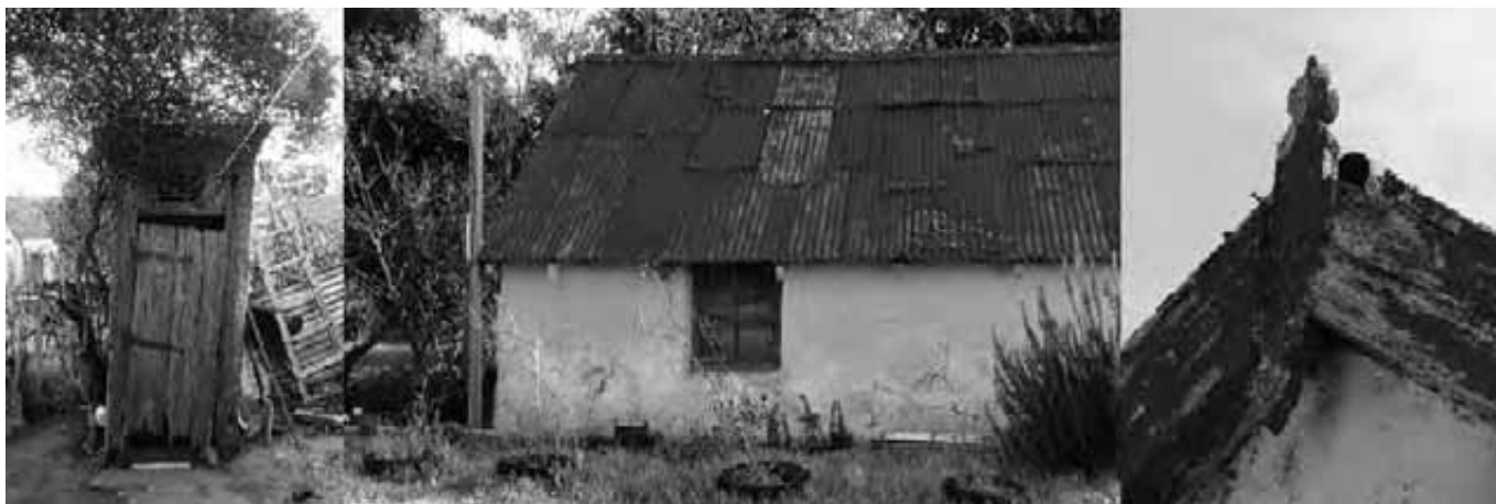
Figura 4. Letrina de madera y chapa / Vivienda que conserva características originales / Coronamiento de testero Fuente: fotografías del autor
