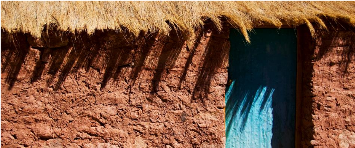
Imagen 4: Pueblo Rinconada, Jujuy, Argentina. Puna Argentina. Detalle de materialidad y textura. Encuentro Techo – Muro.
