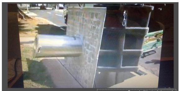
Base de buzón rebatible del basurero subterráneo simula un pedazo de la vereda que se levanta para poder acceder al depósito contenedor con fondo en el espacio subterráneo de 2,00m. de profundidad bajo el nivel de piso terminado.
