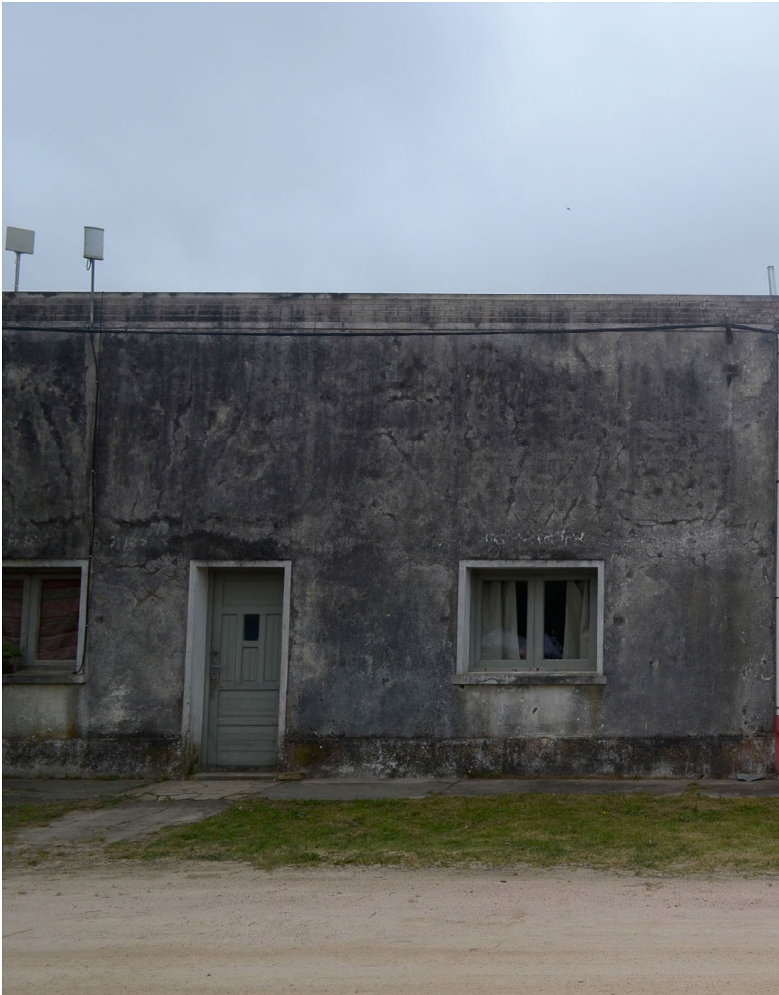
Pueblo Garzón, detalle de fachada.
