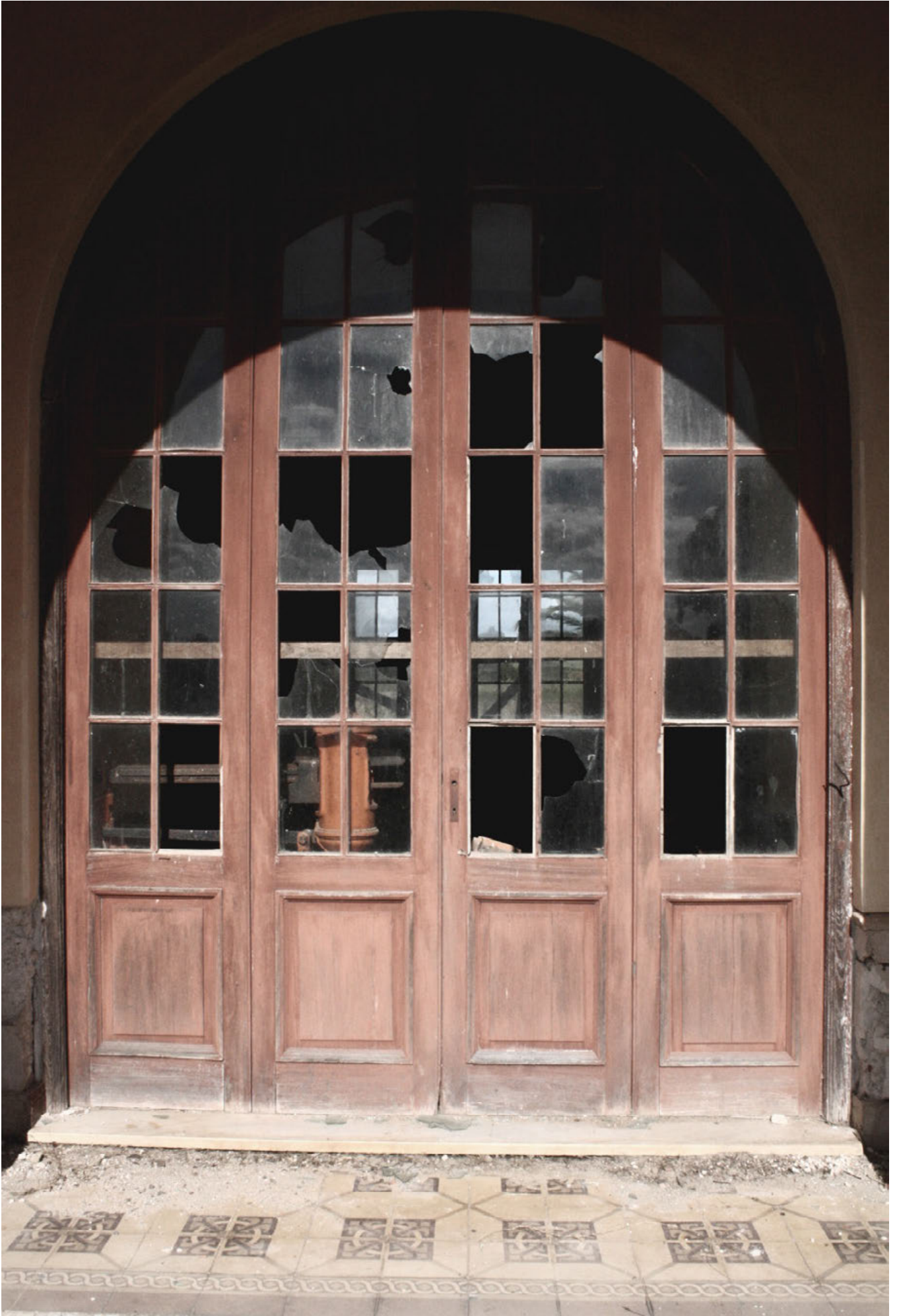
Antigua estación de tren abandonada.
