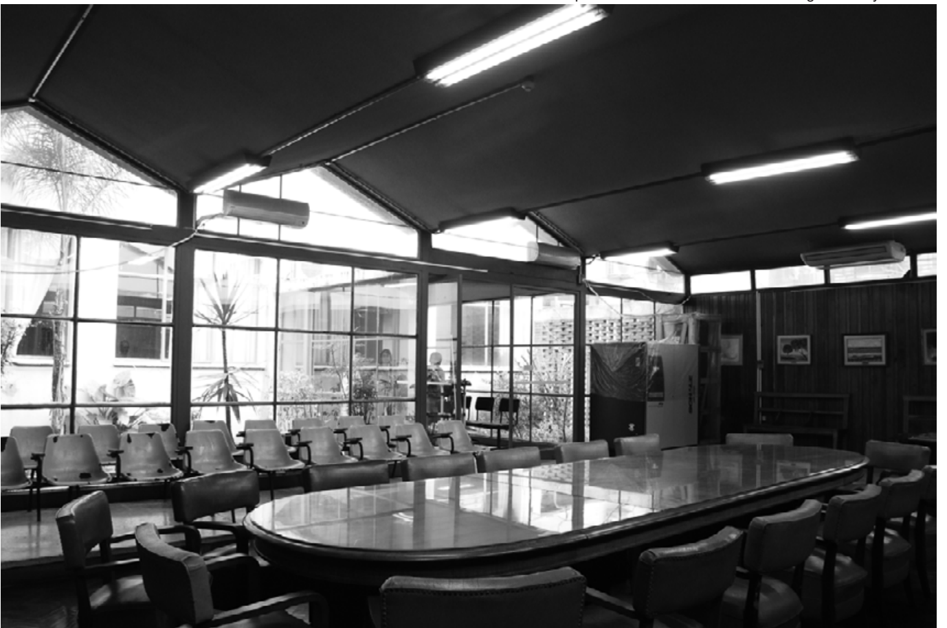
Facultad de Odontología Sala del Consejo. Observese el plegado de la cubierta. Ampliación de la década de 1970 a cargo de Nelly Grandal
