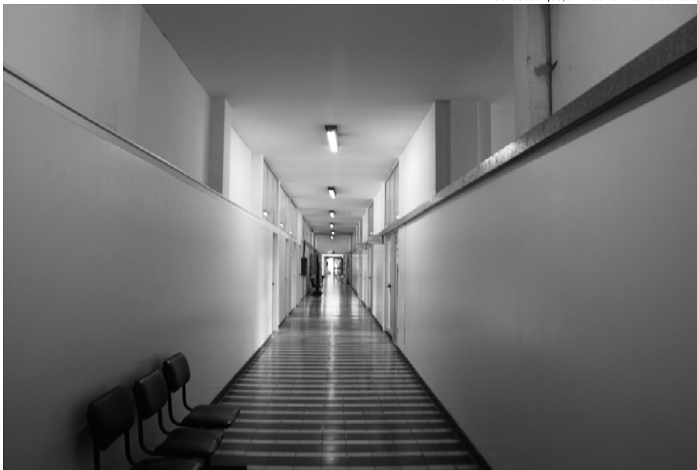
Facultad de Odontología Corredores del piso 1 Observese el recurso en el sector superior de los tabique, a fin de iluminar el corredor
