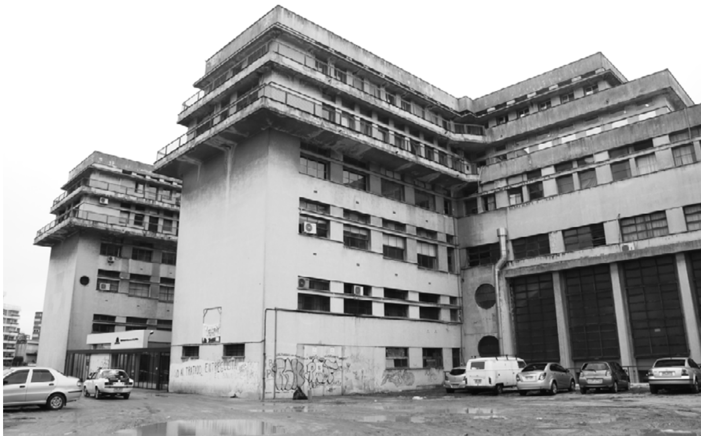
Fachada posterior (norte) Instituto de Higiene Observesé las ventanas en desnivel Corresponden a los salones escalonados
