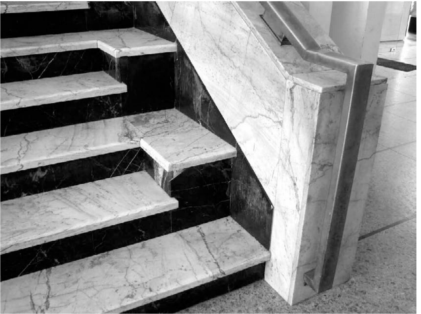
Instituto de Higiene Detalles de la escalera del hall de acceso en mármol blanco y mármol negro
