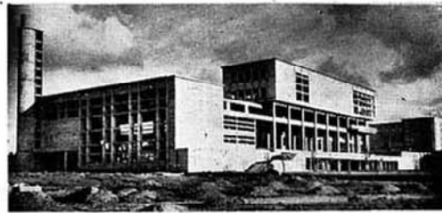
Parte en construcción
