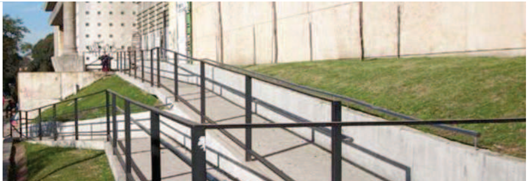
obras de accesibilidad
