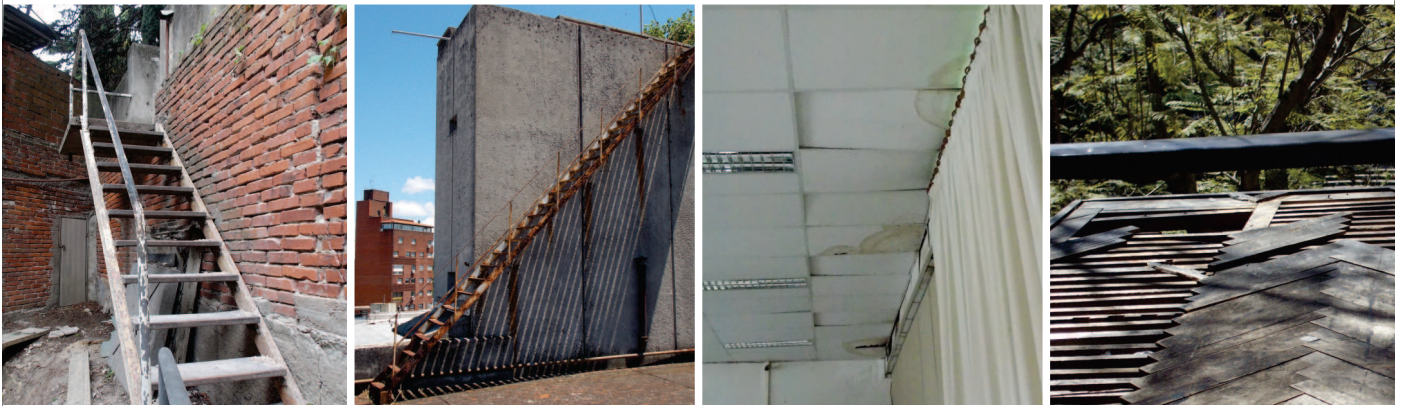
deterioro de revocos, cielorrasos y de carpintería de hierro, madera
