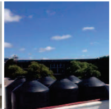
instalación de la red hídrica
