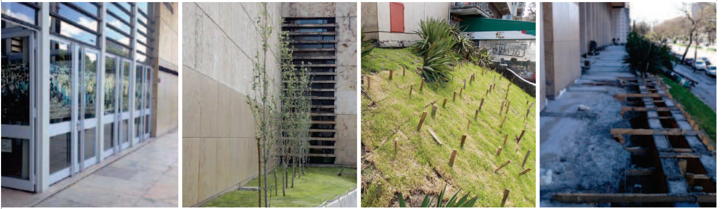
reparación de patologías, recuperación de fachadas y espacios exteriores
