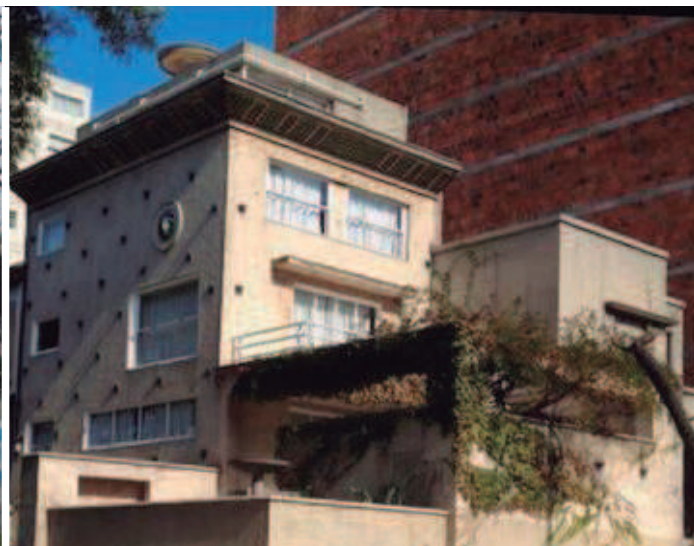
recuperación de fachada
